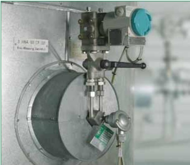
Desde o início, o termo “Sonda-SDF” esteve ligado a medições de gases sujos, corrosivos e carregados de água e pó.
