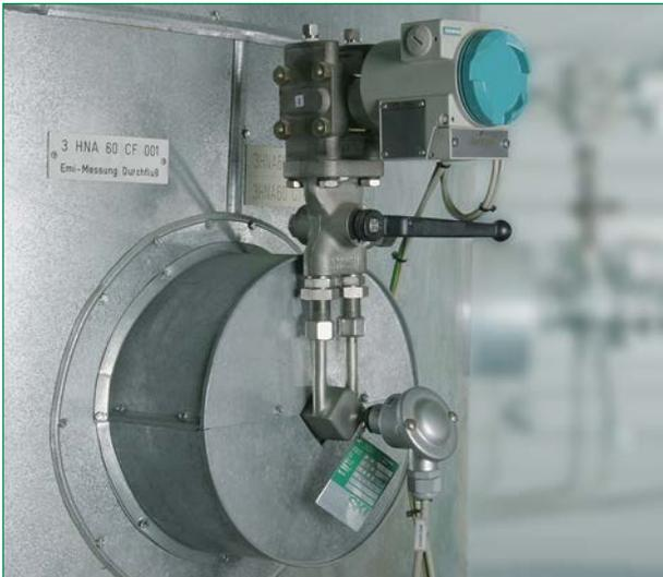
Von Beginn an war der Begriff „SDF-Sonde“ verbunden mit der Messung von verschmutzten, korrosiven und mit Wasser und Staub beladenen Gasen.
